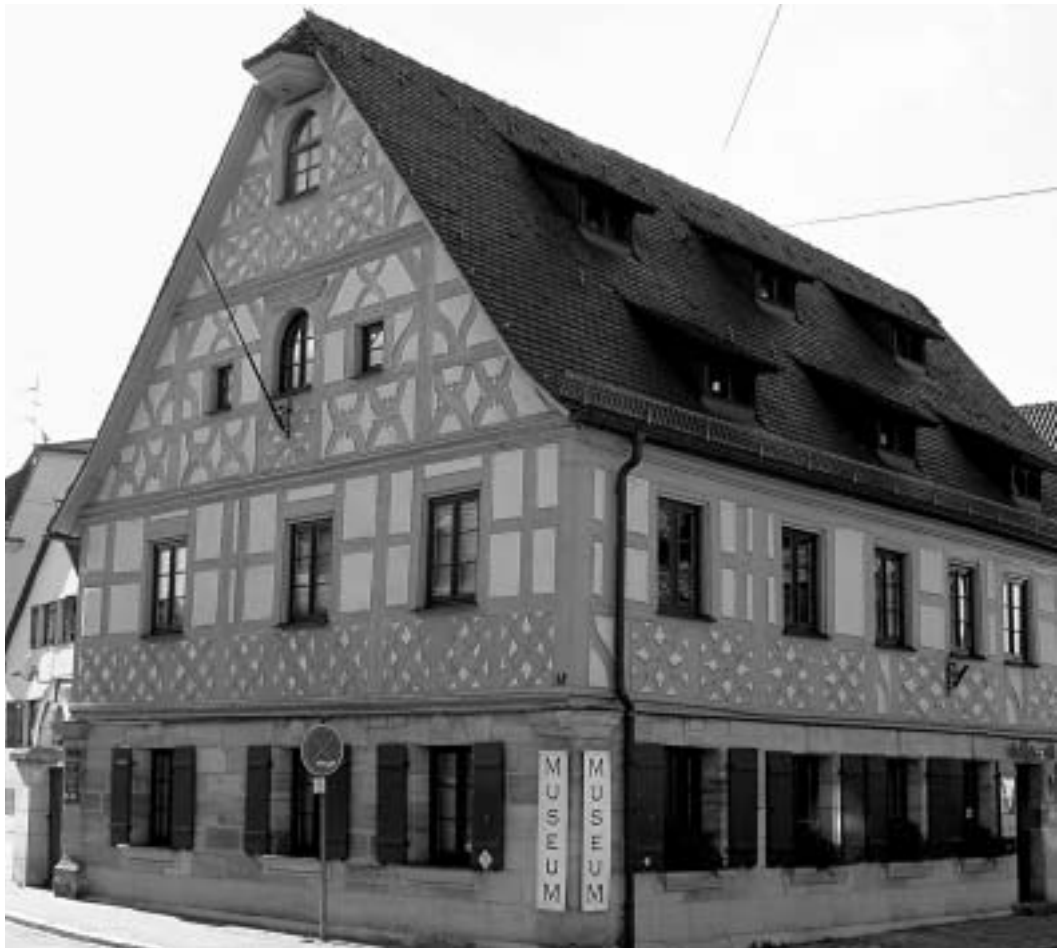
Bild 3: Das Museumsgebäude, einst Gasthaus zum Hirschen, mit einer prächtigen Fachwerkfassade von 1640
