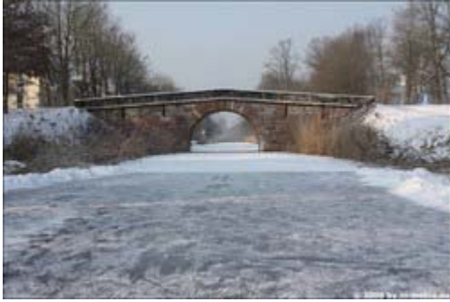
Brücke bei Schloss Kugelhammer
