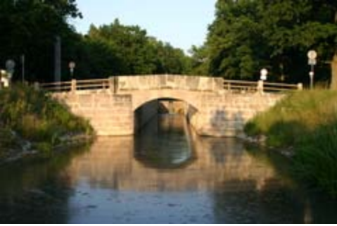
Schleuse bei Feucht
