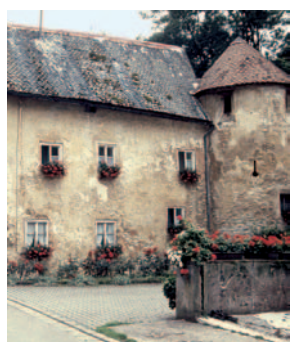
Das Torwärterhaus der Burg Hofberg
