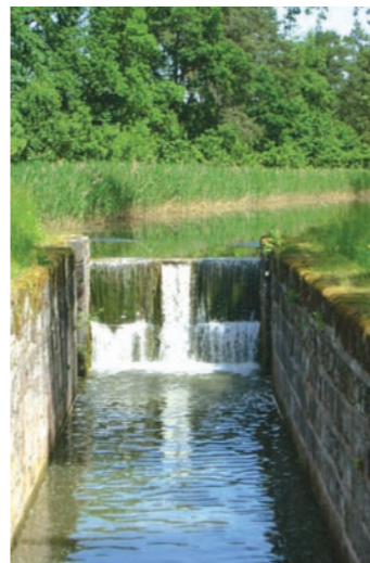
Kanalschleuse bei Pfeifferhütte
